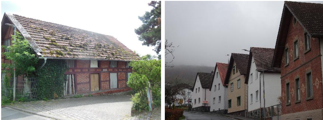
Abbildung 46: ehemaliges Trockenhaus (Bleichstraße) und Bebauung in der Frankensteiner Straße
