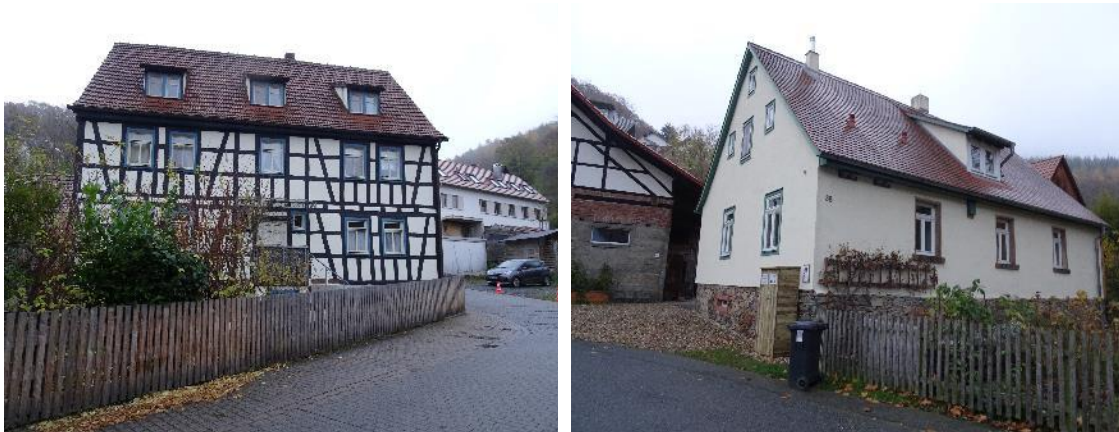
Abbildung 49: sanierte private Bausubstanz in Stettbach
