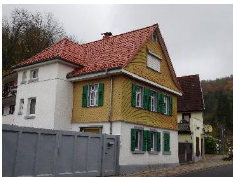
Abbildung 53: Holzschindelverkleidung im Obergeschoss in Jugenheim
