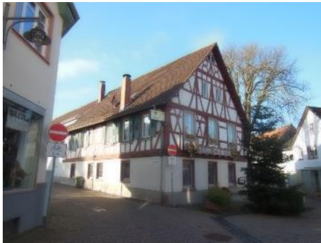
Abbildung 51: Fachwerkfassade über gemauertem Erdgeschoss in Seeheim
