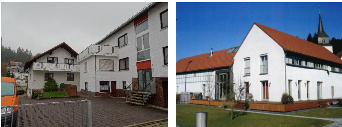
Abbildung 47: Ersatzbauten im Bereich ehemaliger Hofstellen und beispielgebende Umbaumaßnahme einer Scheune zu Wohnzwecken
