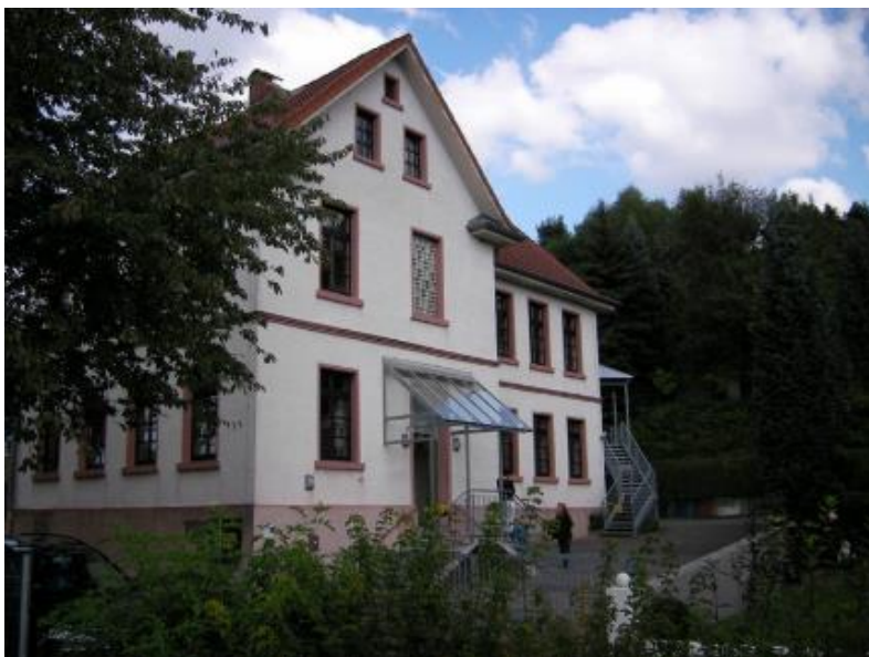
Abbildung 87: ev. Gemeindehaus Ober-Beerbach
