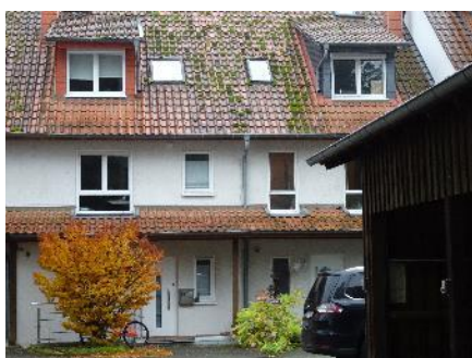
Abbildung 59: Umnutzung bzw. Ersatz von Scheunen zu Wohnzwecken in Ober-Beerbach
