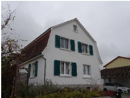
Abbildung 57: Mansarddach in Jugenheim
